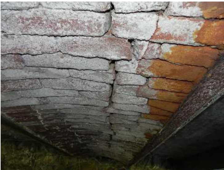
Detail – LS, původní konstrukce – cihlová klenba, znatelný pokles ve spáře
