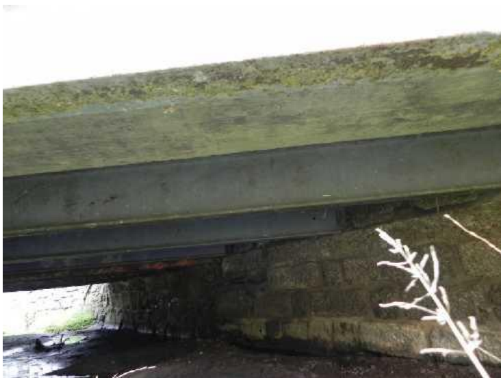
Podhled na nosnou konstrukci - rozšíření
